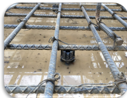
ARMADO DE SILLETAS
